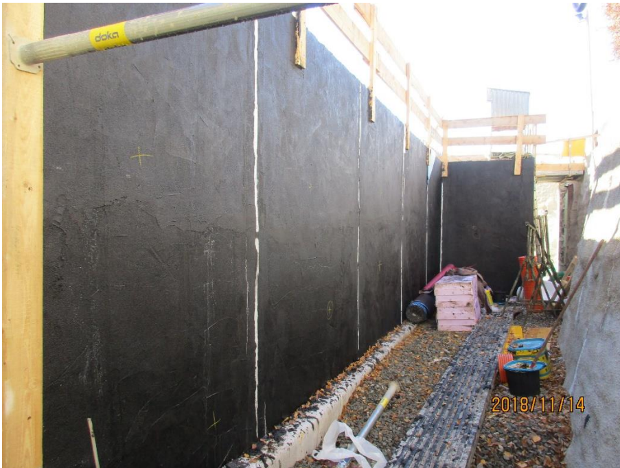
Bauwerksabdichtung nach DIN 18533-3 aus PMBC „Bitumendickbeschichtung“
