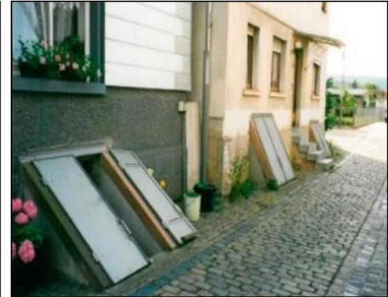
links: Abdichtung eines Kellerabgangs, rechts: Abdichtung von Fenster
