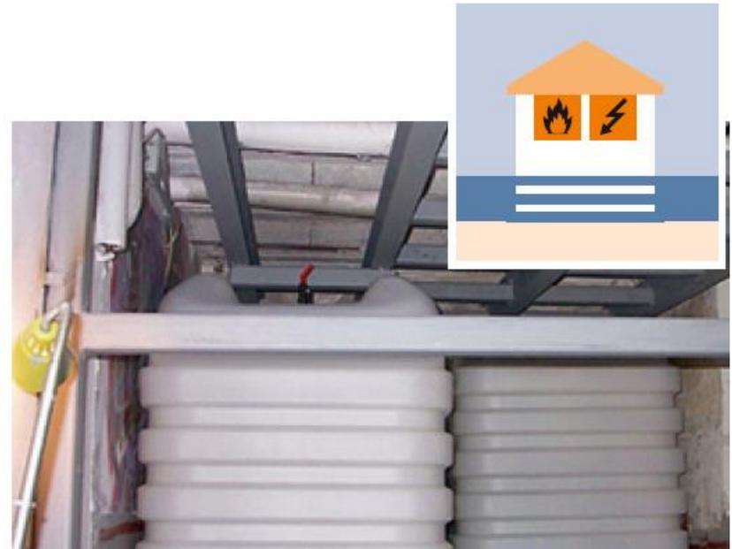
Anpassen: zum Beispiel durch Sicherung bestehender Tankanlagen
