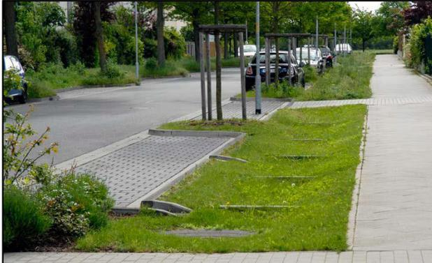
Muldenkaskaden zur Versickerung von Straßenabflüssen
